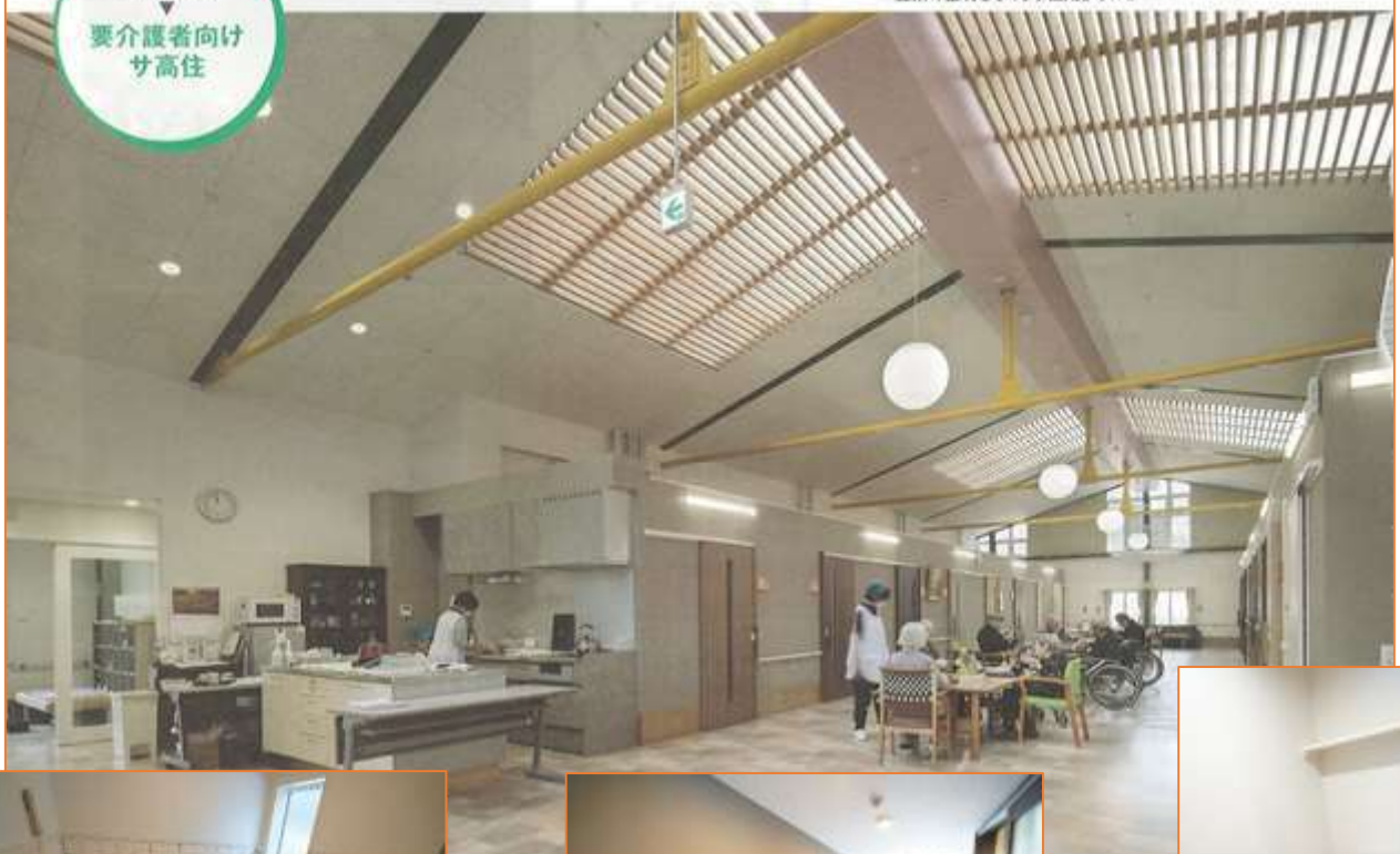
(写真9) 透明屋根を利用して自然採光 既存のトプライトの上部にはポリカーボネートの屋根を設置し、天井の高さを生かしながら、より多くの自然光を取り込めるようにした。黄色い鉄骨などは従来の部材をそのまま使用している。
